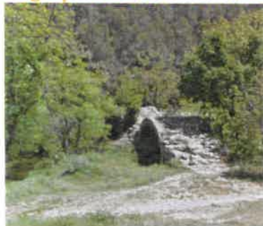
Pont des Deux-Serres sur le Lirou
